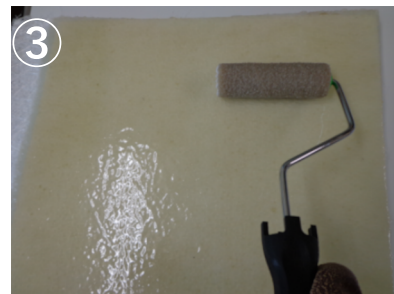
③ 硬化後、ローラーで再塗装
